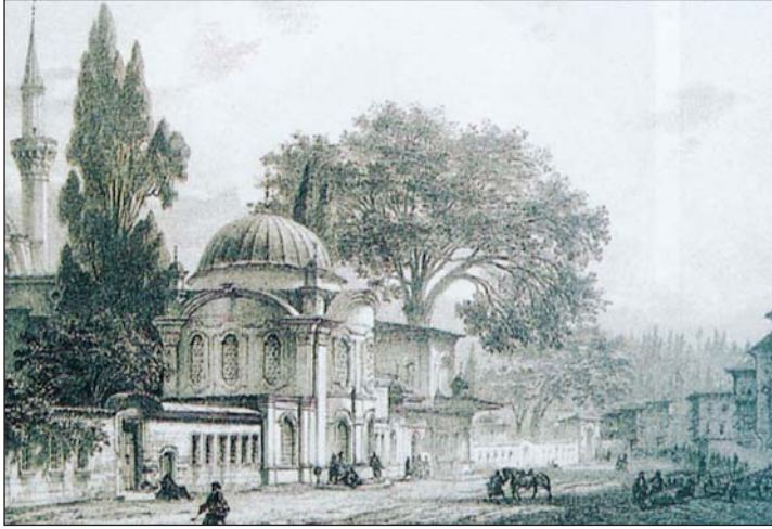
Örnek 8 Eyüp'te Zal Paşa Camii
