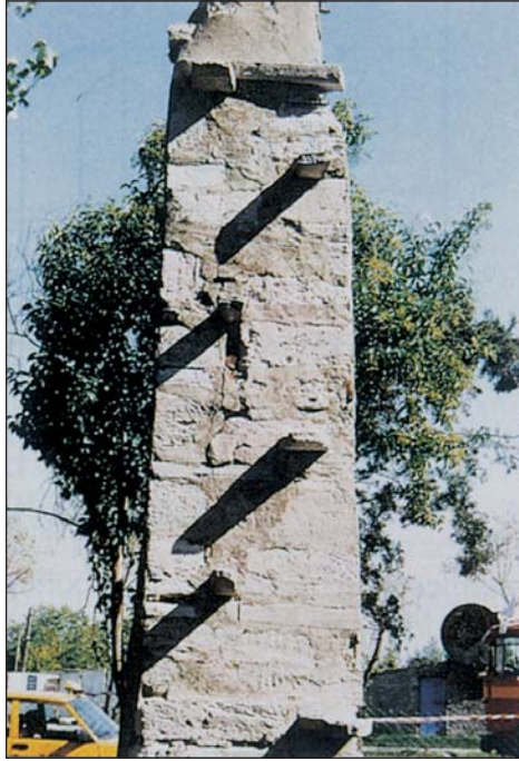
7-Su terazisinin genel görünümü ve merdiven taşları.
