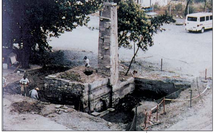
2-Çevresindeki zemin kotunun yükselmesi sonucu çukurda kalmış olan Salih Sultan Çeşmesi'nin genel görünüşü
