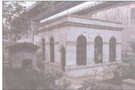
1996 yılı başlarında III. Haliç köprü genişletme çalışmaları sırasında mezarlığın bir kısmı üzerinden vinç geçirilmiştir. (Şubat 1996)
