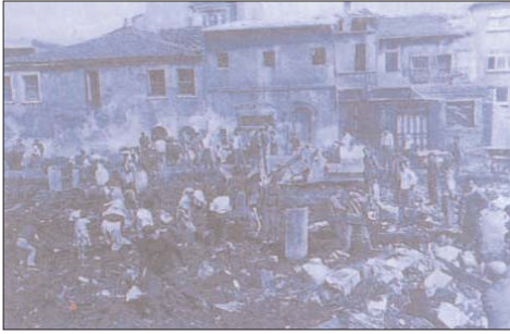
1970'li yılların başlarında Yâ Vedûd'da bulunan Dakik Un Fabrikası yıkılırken.
