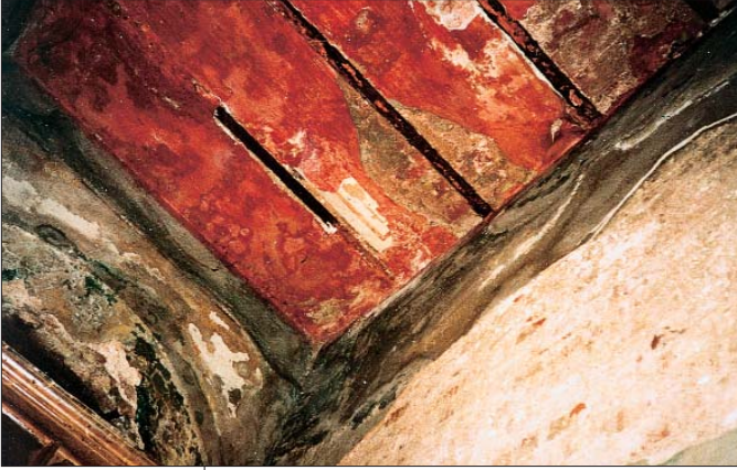
10) Kaptan-ı Derya Hasan Hüsnü Paşa Türbesi/volta döşemeden ayrıntı
