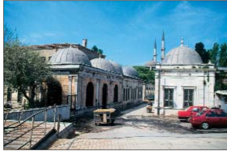
14) Adile Sultan, Hüseyin Paşa, Halil Rıfat Paşa Türbelerinin oluşturduğu siliyet
