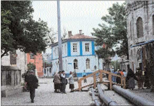
1921'de inşa edilen Eyüp Karakolu'nun 1998'deki görünüşü
