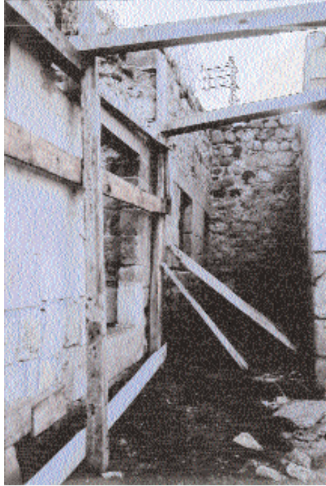
Resim 18. Avlunun güneybatısındaki koridor A.T.Y. saydam arşivi, Aralık 1998
