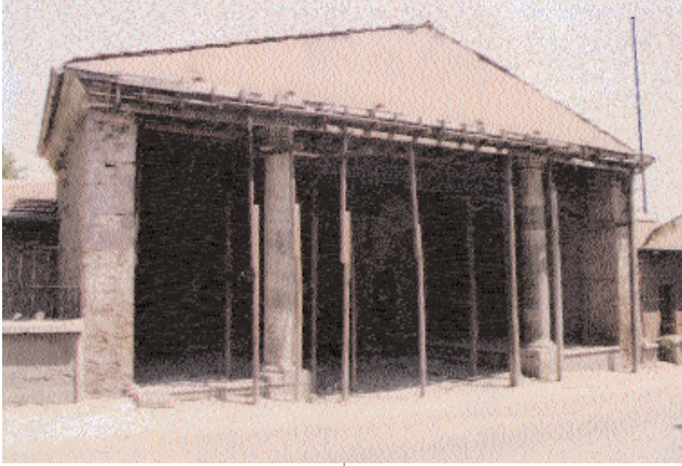
Fotoğraf 3: Güney/Ön Cephe'deki ana giriş revakı (Restorasyon sırasında)
