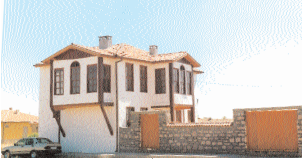
Resim 25: Karatay Belediyesi'nce Yeniden Yapılan Geleneksel Konya Evi
