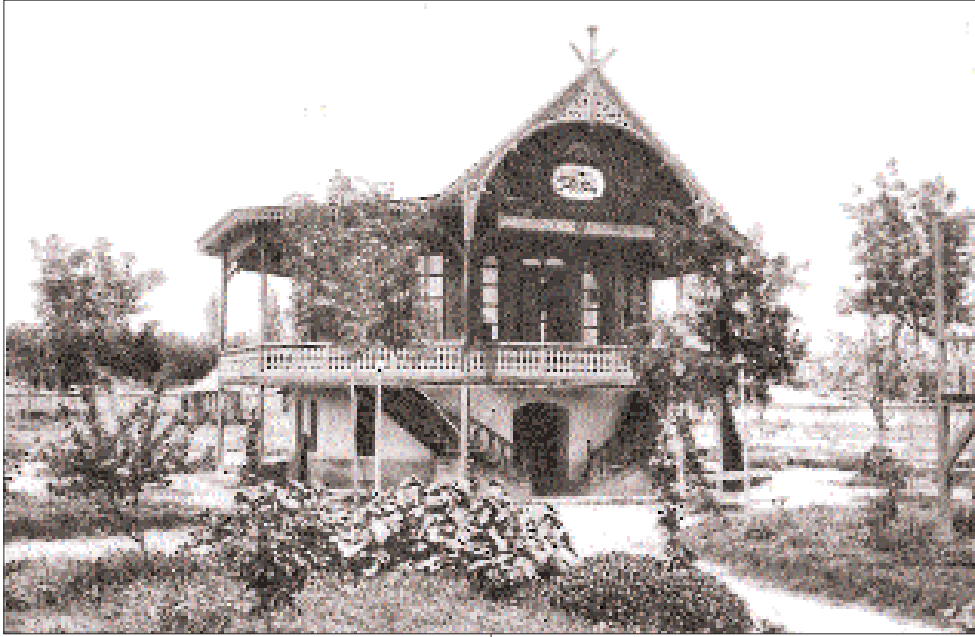
Resim 23: Belediye Bahçesindeki Yıkılan Köşk
