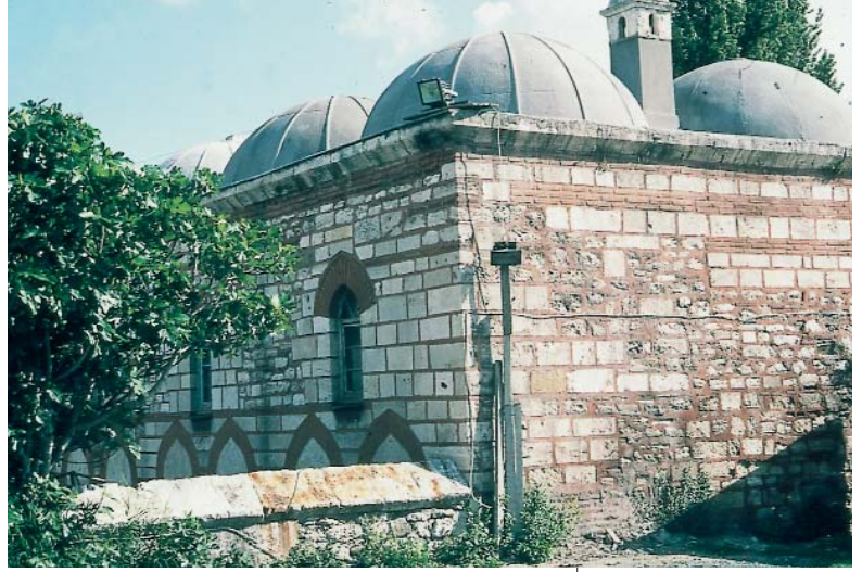
(Resim 1) Sokollu Mehmet Paşa Medresesi, Güneybatı köşesi, almasma oranının onarımlarla değişmesi.
