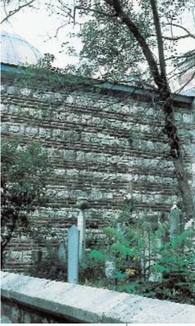
(Resim 2) Sokullu Mehmet Paşa Medresesi, Dershane özgün duvarı ve bir sıra taş üç sıra tuğla almasıık duvar.
