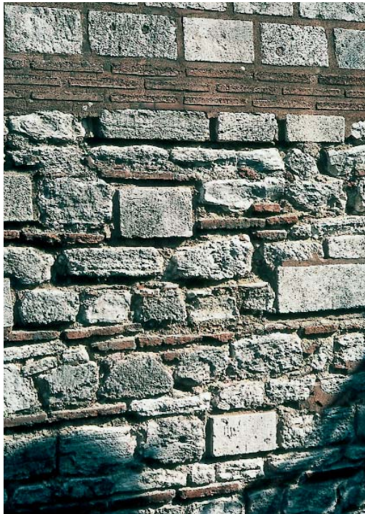
Resim 4; Özgün almaşma düzeninin bozulması.
