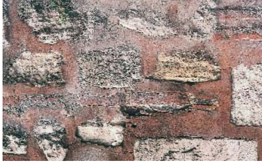
Resim 3; Yanlış derz onarımı tekniği nedeniyle, taş yonu tekniğinin tahrifatı. Düzgün kesme taş duvar cidarı giderek kaba yonu taş duvar görüntüsüne dönüşmektedir.
