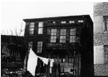
Foto 24- 64 ada 1 parseldeki tescilli konut yıkılmış, Erdem 2001.
