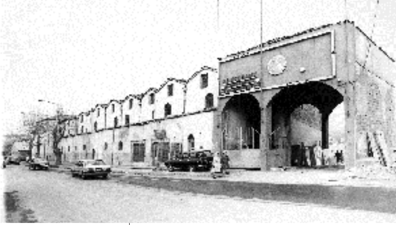
Resim 6; Feshane'nin yıkılmazdan önceki son görüntülürü (Eyüp Belediye arşivi)
