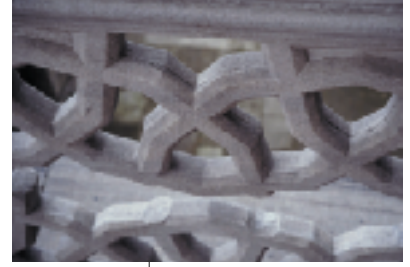
Resim-1; Zal Mahmut Paşa son cemaat yerinde mermer şebeke korkuluğunun suyunu paralel olarak iç yapısındaki kusurun ortaya çıkması sonucu meydana gelmiş çatlama,
