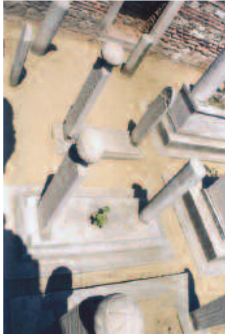
18: Cafer Paşa Türbesinin yapılan çalışmalardan sonraki durumu.
