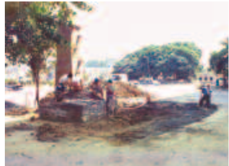
4: Saliha Sultan Çeşmesinde yapılan çalışmalar.
