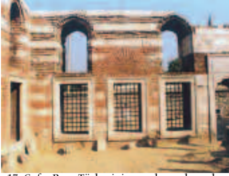
17: Cafer Paşa Türbesinin yapılan çalışmalardan sonraki durumu.
