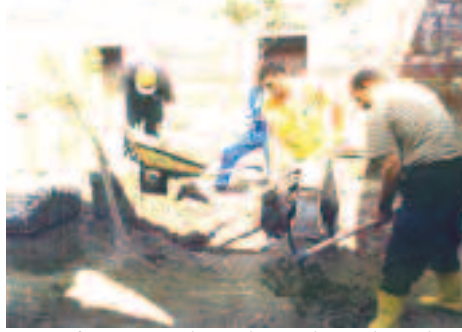
12: Cafer Paşa Türbesinde yapılan çalışmalardan bir ayrıntı.
