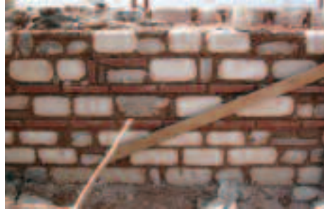
Resim 9. Tekfur Sarayı restorasyonu horasan harcı uygulaması
