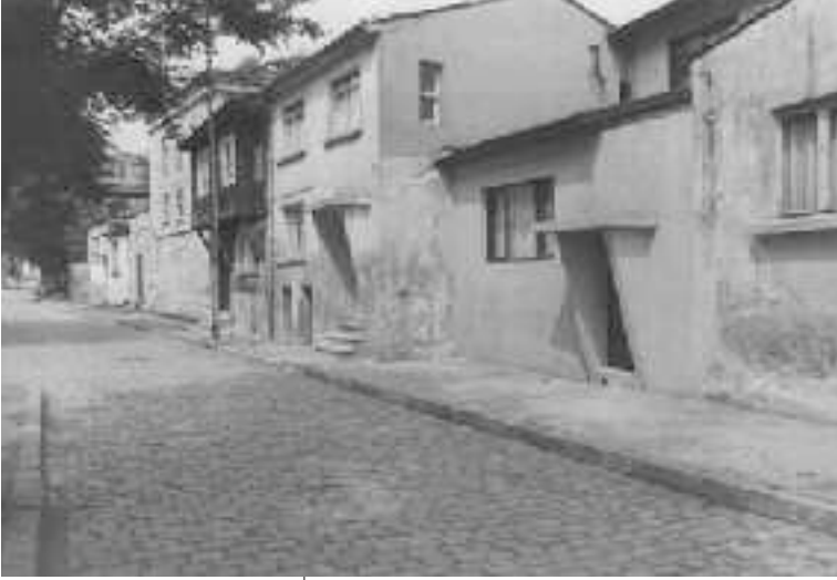
Resim3: Yenileme öncesi, İdris Köşkü Caddesi'nden görünüş
