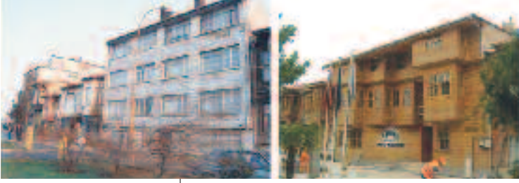
Resim 23-24: Kızılmescid Sokak, 1992, 2006. Günümüze ulaşamamış ve özgün durumuna dair yeterli belge bulunamayan yapıların yeniden inşa edilmesinde yörenin karakteristiğine uymayan biçimleniş özelliklerinin kullanılmasına bir örnek
