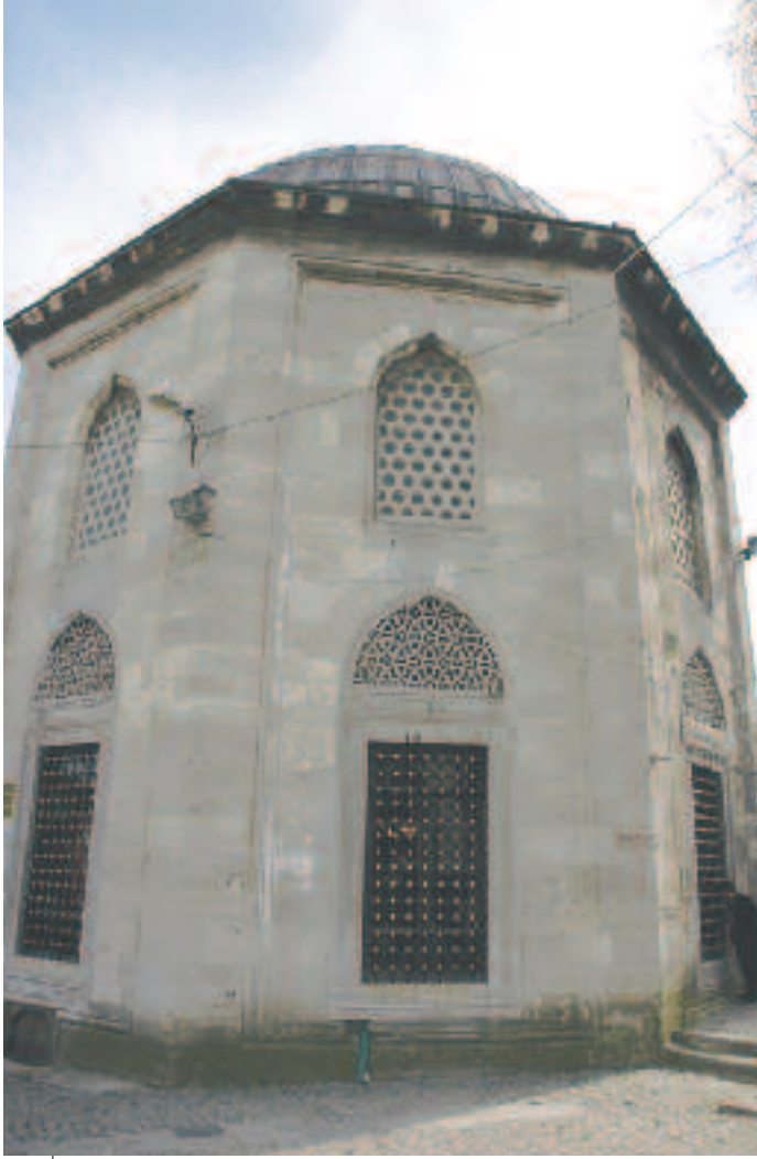
9: Sokullu Mehmet Paşa Türbesi'nin cami-i kebir caddesinden görünümü
