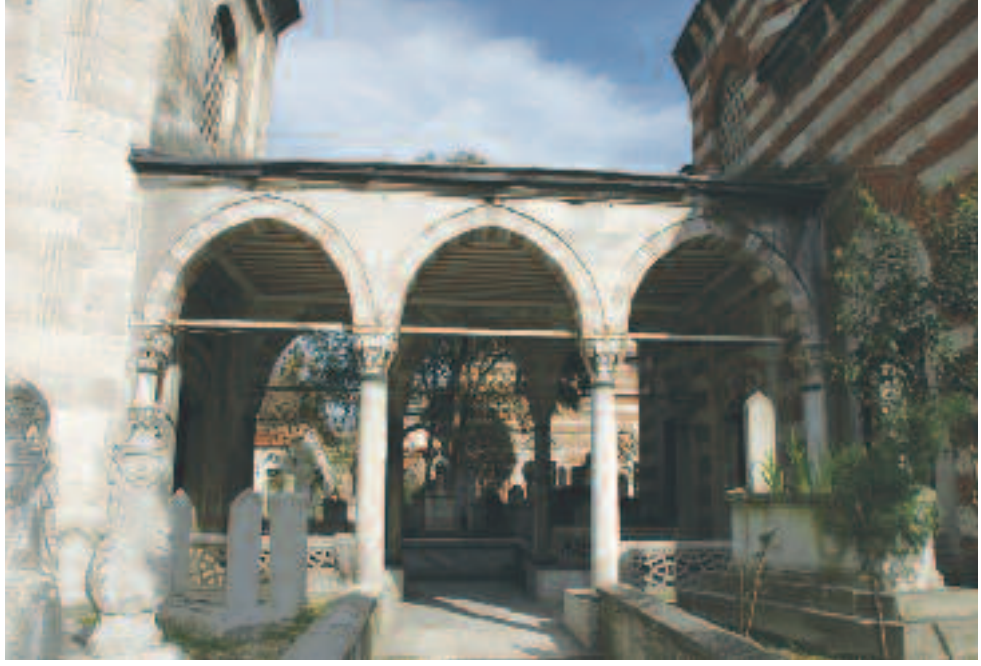
2: Sokullu Mehmet Paşa türbesi ile medresenin dersanesi arasındaki revaklı bağlantı
