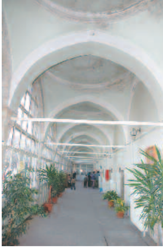
5: Sokullu Mehmet Paşa Medresesi'nin revaklı geçişinin içerden görünüşü. Revaklar bugünkü kullanımına göre kapatılmıştır.
