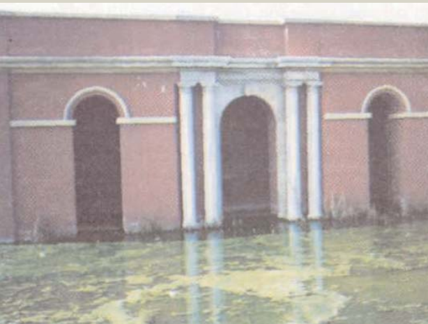
■ Feshane-i Amire cümle kapısının 1995 kışındaki feci durumu
